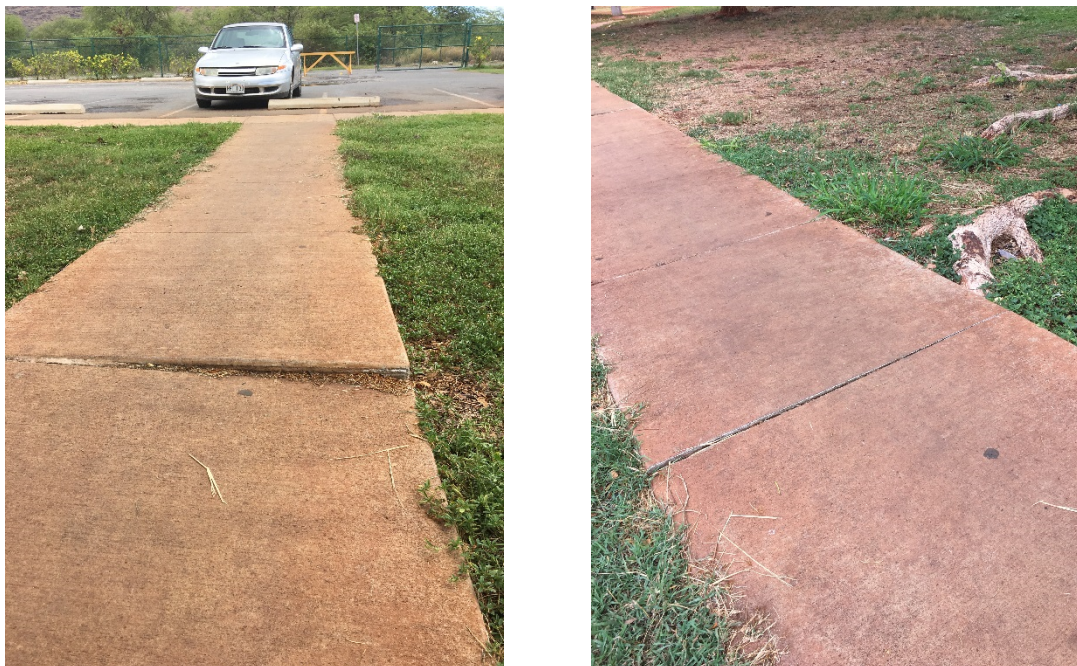
Photo 2.3. Uneven Pavement
